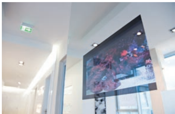
Abb. 3: Insgesamt sechs Flatscreens sind in den Behandlungsräumen und im Wartebereich installiert.
