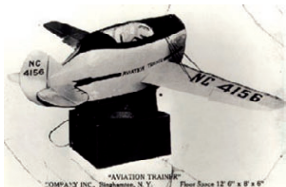
Abb. 2: Erster Flugsimulator aus dem Jahr 1929, hergestellt von Ed Link (USA).
